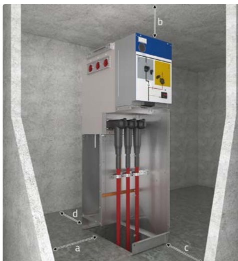
Distancias mínimas de instalación [mm] (pies/pulgadas)
